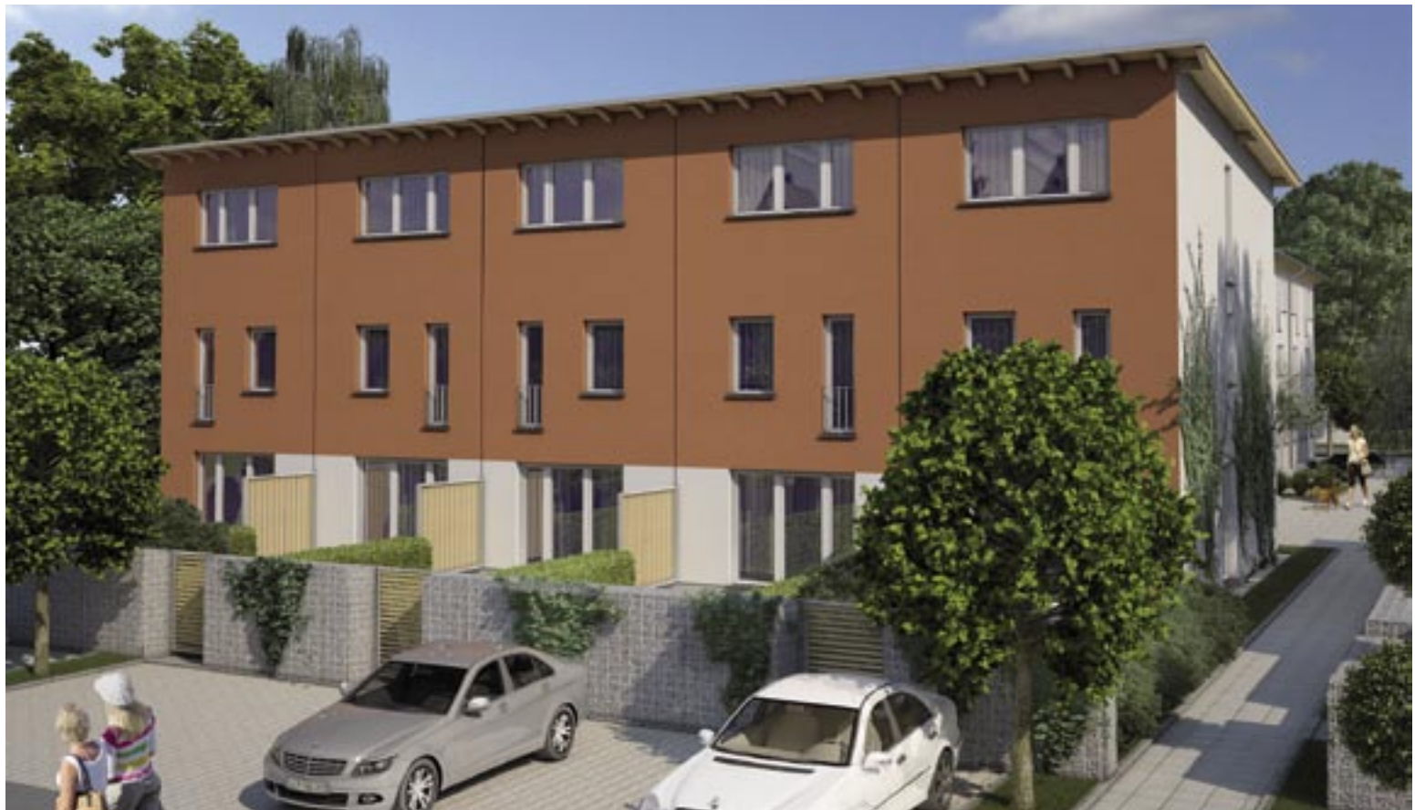
Referenzbilder aus dem I. Bauabschnitt
